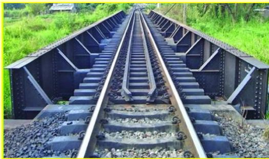
บูรณะทางเดิม
